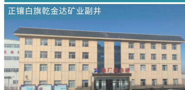
正镶白旗乾金达矿业副井 6绳高效更换项目
