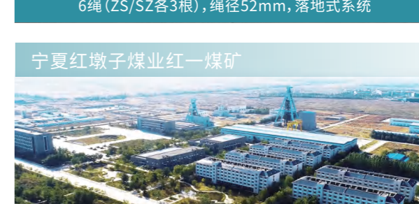
宁夏红墩子煤业红一煤矿 主副井同步施工(主井首绳+副井扁尾绳)
