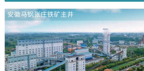
安徽马钢张庄铁矿主井 6绳井塔式系统, 绳径44mm, 提升高度655m
