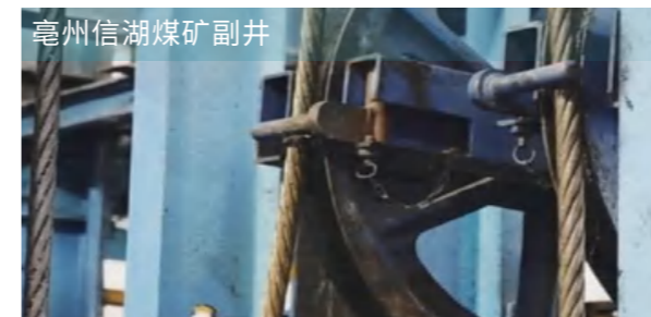
亳州信湖煤矿副井 千米井深, 2套8绳同步更换(绳径50mm/40mm)
