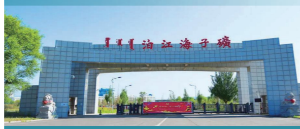
宽窄罐与交通罐系统一体化更新
