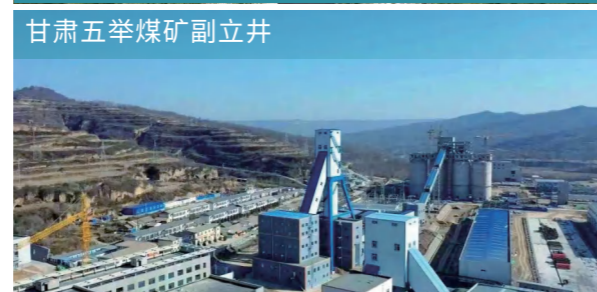
甘肃五举煤矿副立井 4绳宽窄罐系统, 同步安装8个张力检测油缸
