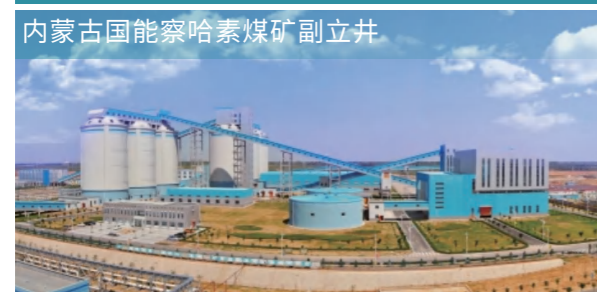
内蒙古国能察哈素煤矿副立井 大罐6绳+交通罐4绳双系统混合更换
