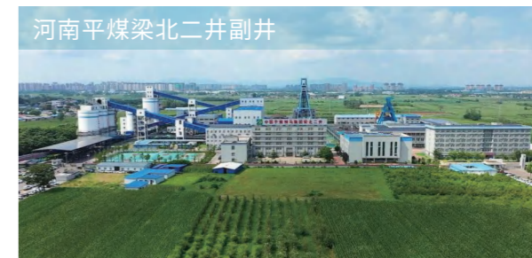
河南平煤梁北二井副井 4绳更换, 7小时创高效纪录
