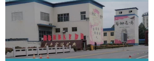
主井装备与矿仓综合性改造
