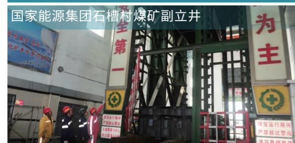
国家能源集团石槽村煤矿副立井 4绳+8悬挂同步更换
