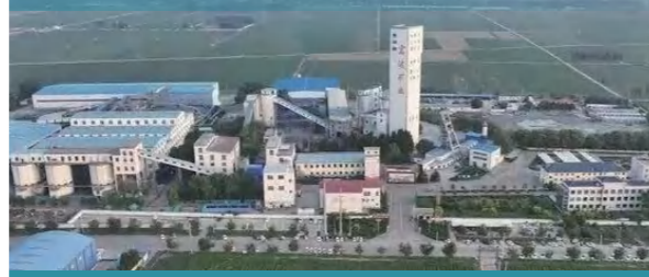
6绳更换+1绳调整复合工程
