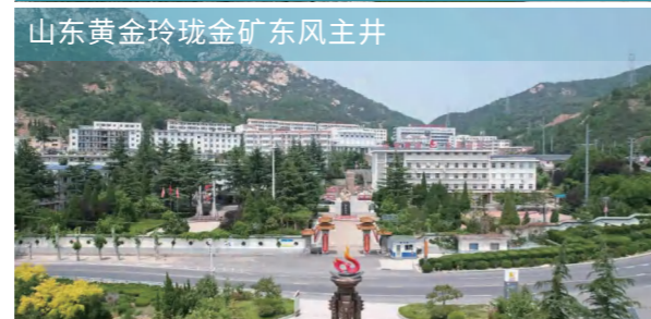
山东黄金玲珑金矿东风主井 4绳, 绳径40mm, 井深988m(深井金矿代表)
