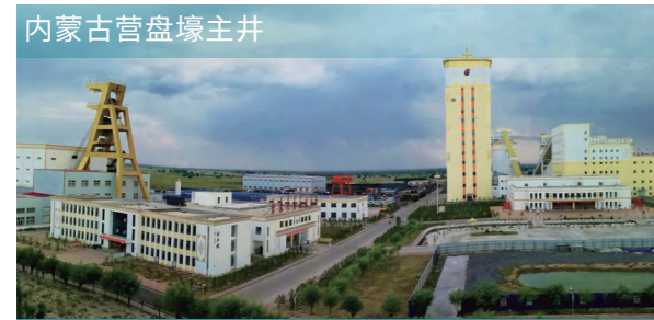
内蒙古营盘壕主井 6绳井塔式, 绳径48mm, 提升831.24m
