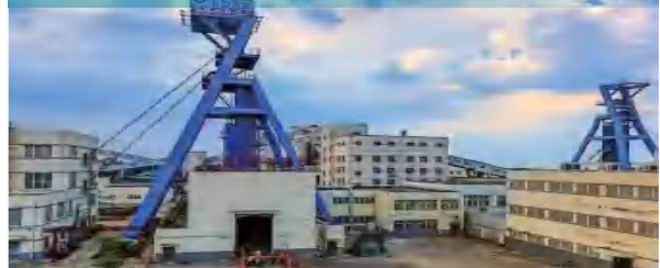
安徽皖北煤电五沟煤矿
