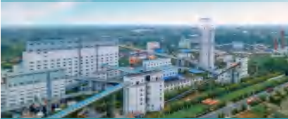
安徽马钢张庄铁矿主井
