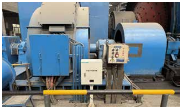
攀枝花钒钛磁铁矿 “高压电机绝缘监测”与智能开关联动,构建关键设备健康管理体
