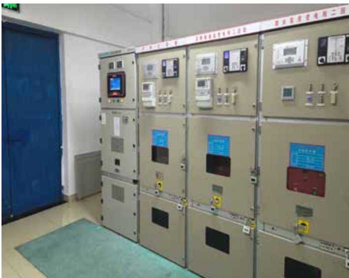
贵州金沙龙凤煤业 “过压抑制PT柜改造”根治雷击跳闸顽疾
