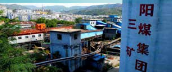
辽宁沈阳焦煤红阳三矿1#主井
