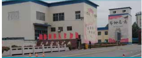
主井装备与矿仓综合性改造
