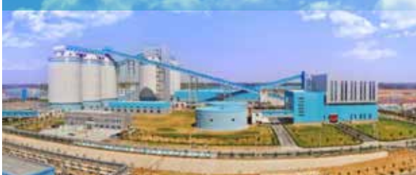
内蒙古国能察哈素煤矿副立井
