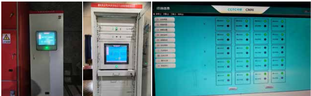
贵州开磷矿山 & 云南大红山矿业 “高压电缆CMAI系统” 实现精准预警定位, 变抢修为计划
