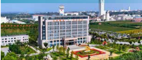
山东焦家金矿寺庄分矿主竖井
