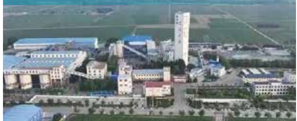
6绳更换+1绳调整复合工程
