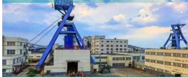
安徽皖北煤电五沟煤矿
