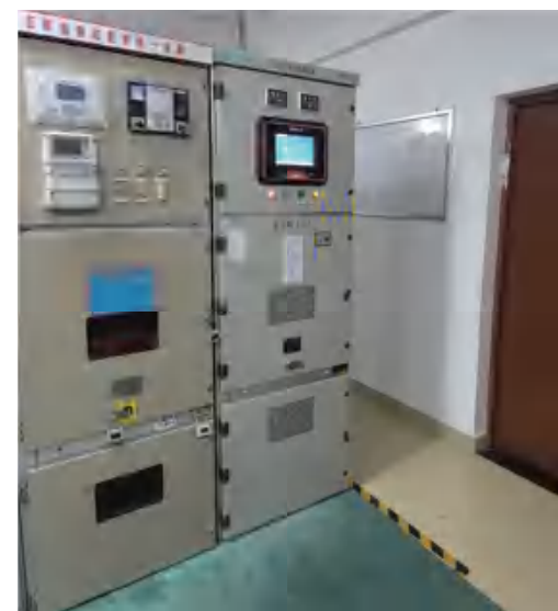
贵州金沙龙凤煤业 “过压抑制PT柜改造”根治雷击跳闸顽疾
